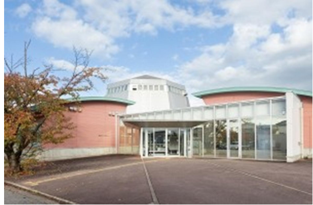
7 富山ガラス工房 第2工房
